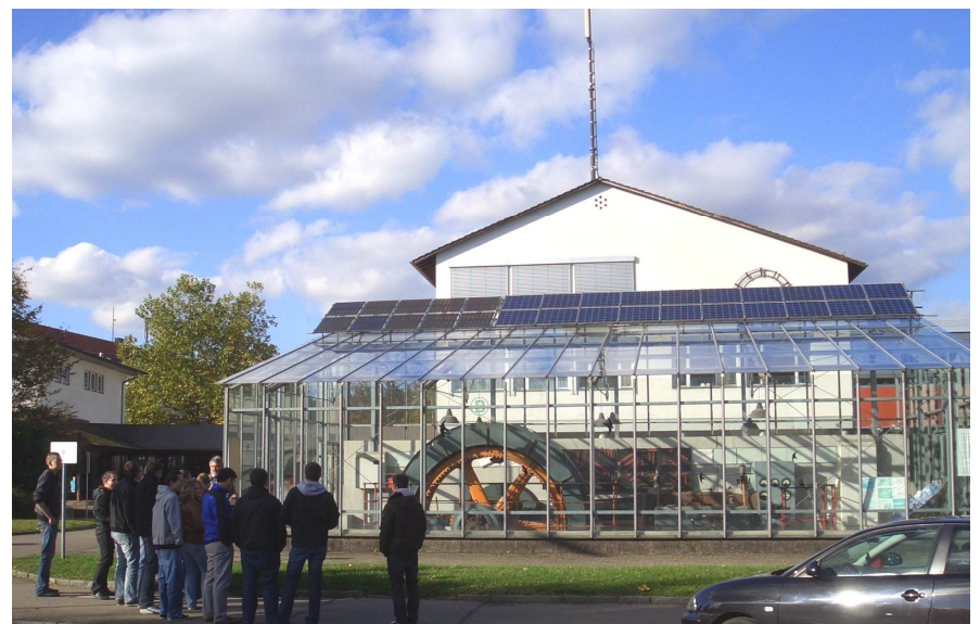
Besichtigung der alten PV-Anlage Klasse E3GS
